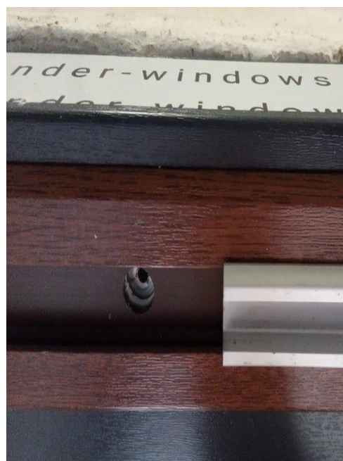
Rys... Otwór na dybel pod górną szyną.
