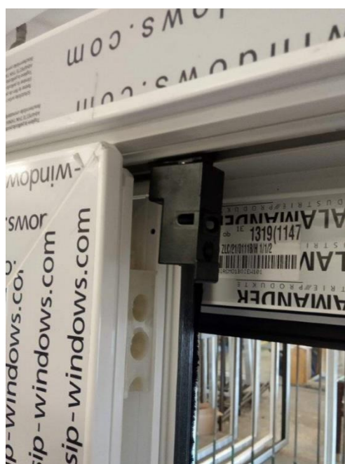
Rys.... Demontaż wieszaka.
