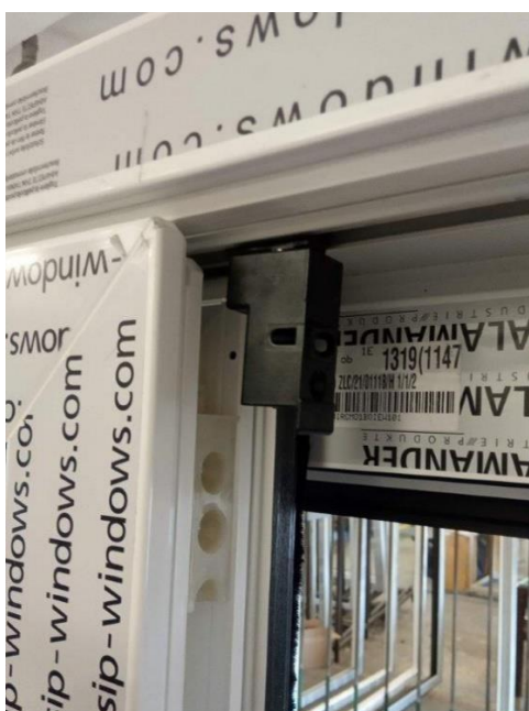
Obr. .... Demontáž věšáku. horní kolejnici.
